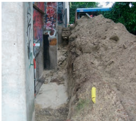
Bodenaushub für den Wärmesee
