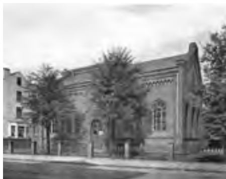
Turnhalle der Schule an der Nordstraße
