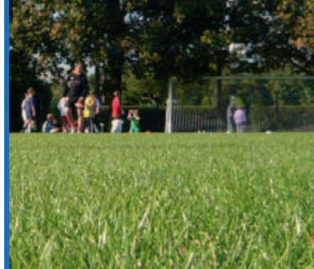
Ein neuer grüner Teppich in unser guten Stube Hohweg: Bis auf den Ballfangzaun ist das Großfeld fertig gestellt. Foto: Jürgen Lange.
