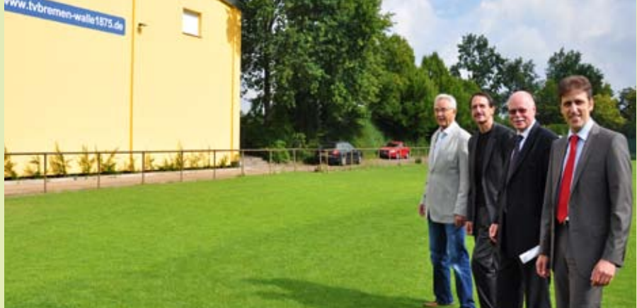
Sie freuen sich über die vorbildlich sanierte Halle des TV Bremen-Walle 1875: Dr. Cornelis Rasmussen, Geschäftsführer der Bremer Energie-Konsens, Sportsenator Ulrich Mäurer, Peter Ott vom Bundesinstitut für Sportwissenschaften und Vereinsvorsitzender Hinze Walter (v.r.n.l.) Foto: Klaus-Peter Berg
