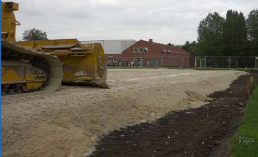
Schreck beim Betreten des Hohwegs: Aber nein, hier wird nicht nach einem verbuddelten Linienrichter aus dem Pokalfinale 1951 gesucht, hier entstehen Kunst- und Naturrasenfelder. Foto: Jürgen Lange
