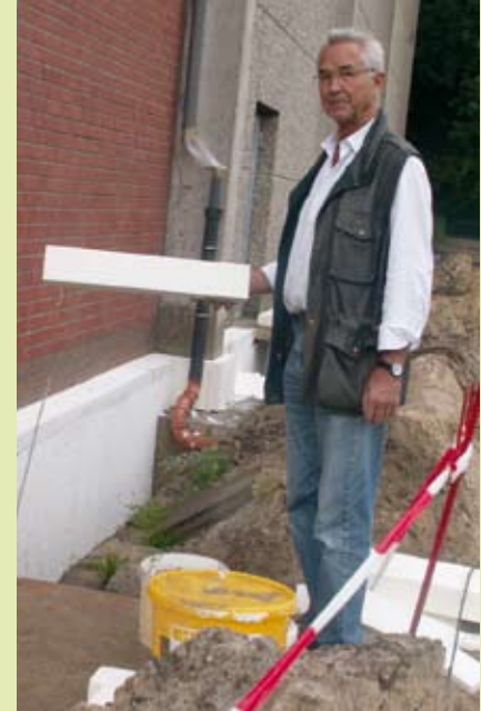
Vorsitzender Wilhelm H. Walter vor dem freigelegten Fundament mit einem Stück der einzubauenden Perimeterdämmung. Um mehr als die Hälfte soll der Energieaufwand nach der Sanierung der Halle am Panzenberg sinken.
