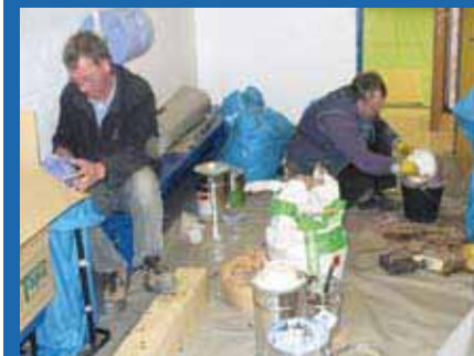
Die AG Bau hat immer ein wachsames Auge auf die Sanierung unseres Vereinszentrums.
